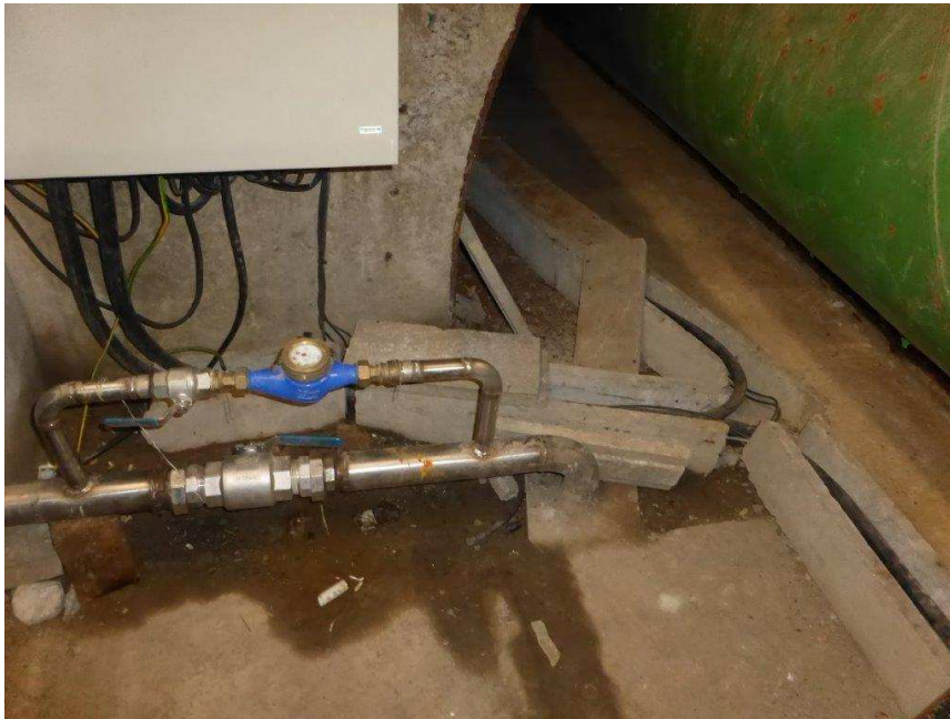
Obrázek – Instalace měřidla na prvním čerpadle
